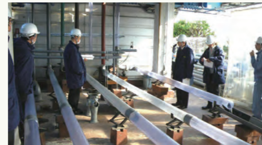
継手を減らし水漏れの原因をなくす。配水管の選択で排水音を低減する等々、建物の付加価値をあげる提案を行います。
