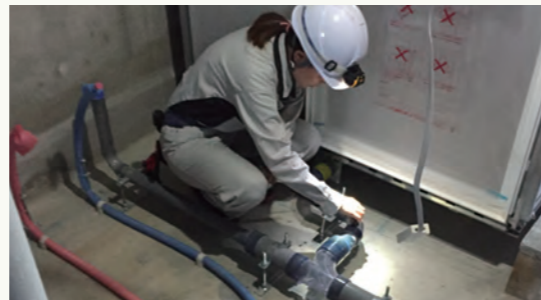
施工状況はその都度、厳しくチェック。疑問点はその日のうちに解決するよう努めています。
